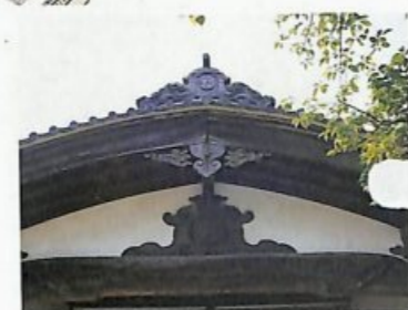
玄関屋根の起り破風と蕪懸魚 ■ 破風とは、軒の三角形部分をさし、破風板が上方に凸形に反ったものを起り破風という。棟木の端を隠す飾りが蕪懸魚で、掛川城御殿のものは蕪懸魚と呼ばれる。
