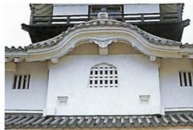
軒唐破風と火燈窓 破風とは、軒の三角形部分をさし、掛川城天守閣に用いられているものは寺社建築に起源をもち、唐破風と呼ばれます。火燈窓は、鎌倉時代以降に禅宗寺院の建築に用いられた窓の型式。ともに城郭の装飾として用いられるようになりました。
